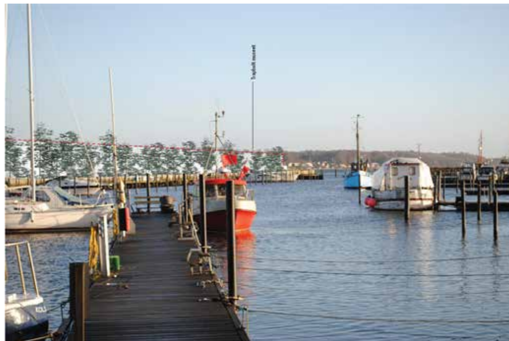
Figur 1-15: Marina City og støjskærm mod erhvervshavnen set fra bådebroen ved Fjordstien. Fotostandpunkt 11 i Figur 1-9.
